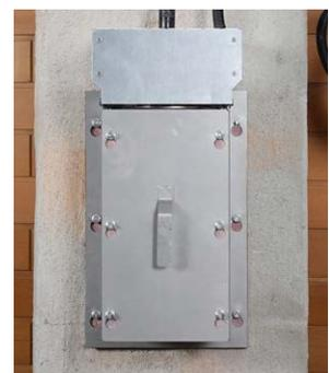
4. Serviceöffnung schliessen und elektrische Verbindung zur Steuerung herstellen
